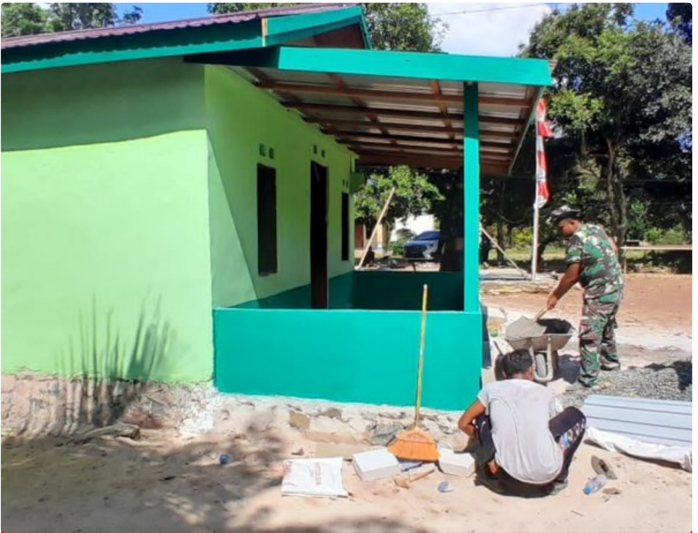
Pengerjaan Rumah Mbah Sandi Hampir Rampung
