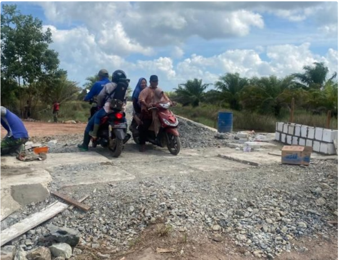
Walaupun Belum Kelar, Jembatan Sudah Bisa Dilewati Warga
